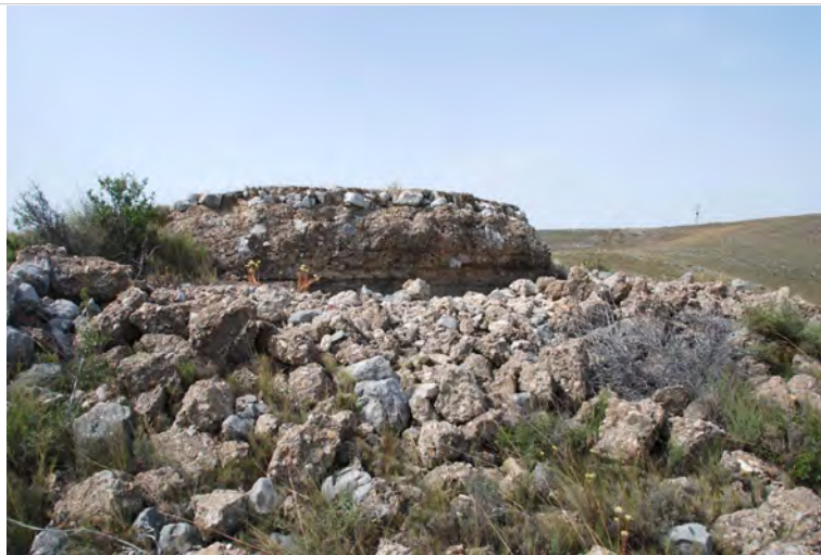
Restos de fortín en hormigón
