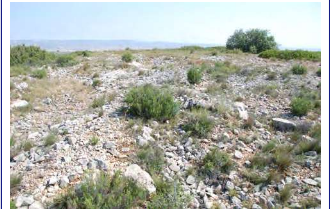
Estado de las trincheras
