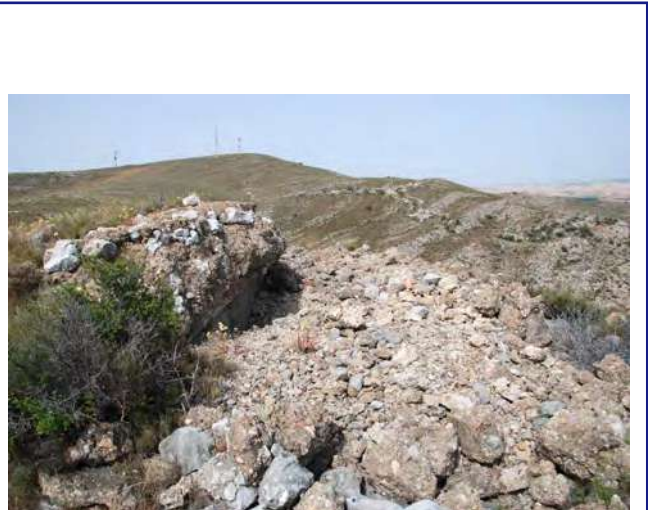
Restos de fortín en hormigón
